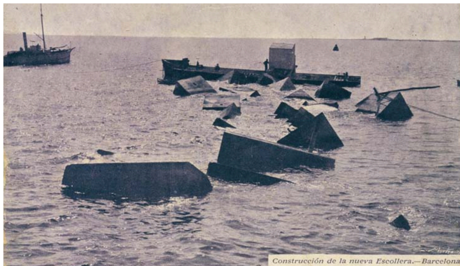
FOTOGRAFIA 69. Llanxassa utilitzada per a construir una secció de l'escollera al port de Barcelona.
