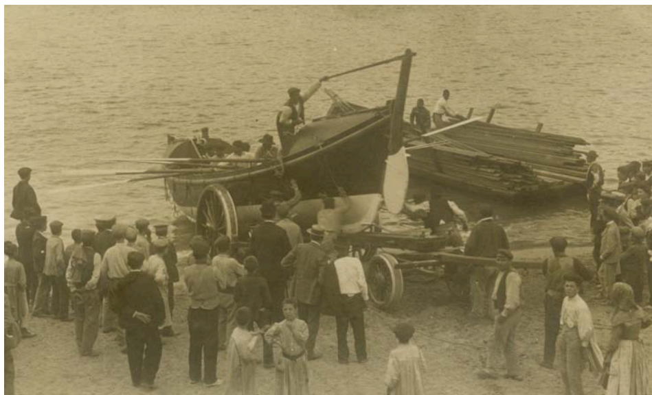
FOTOGRAFIA 65. Bot salvavides d'estació i els dispositius que s'utilitzaven per a varar-lo.
