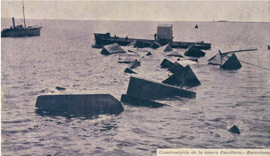
FOTOGRAFIA 69. Llanxassa utilitzada per a construir una secció de l'escullera al port de Barcelona.
