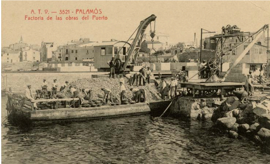
FOTOGRAFIA 39. Pontó al port de Palamós.
