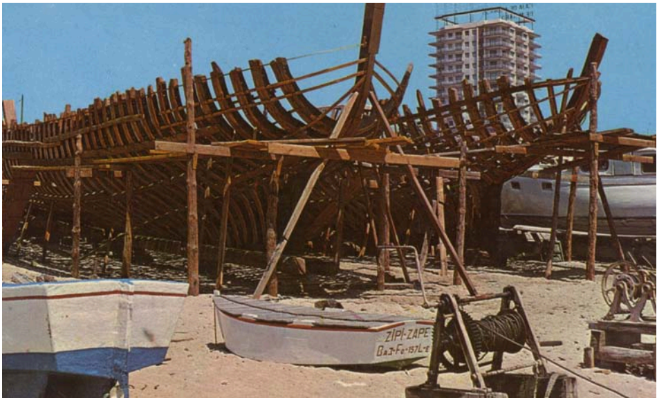
FOTOGRAFIA 41. Al centre, la pastera II Zipi-Zape al davant de dos bastiments en construcció a Mataró.
